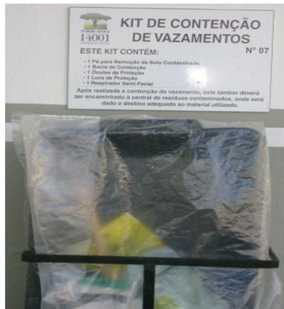
Figura 14 – Kit de Contenção de Vazamentos da área externa Fonte: Concessionária CarHouse , Santa Maria – RS (2010).
