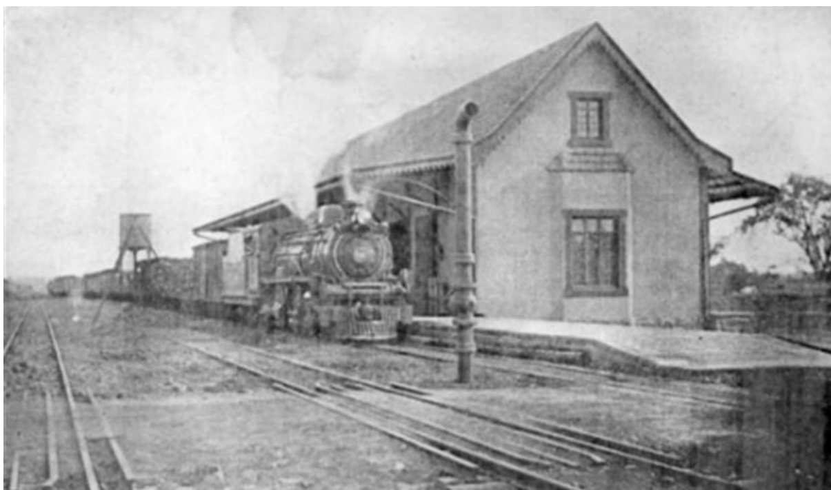
Figura 2 – Estação ferroviária de Restinga Sêca
