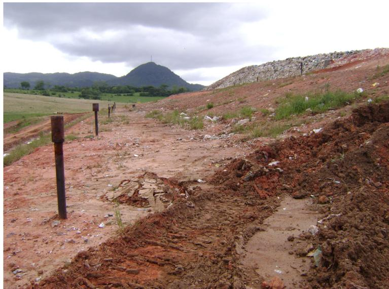
**Figura 45 - Drenos instalados na superfície.**
