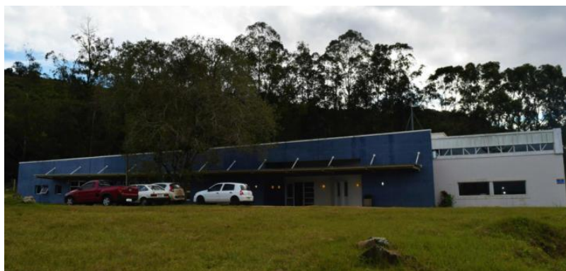
IMAGEM 1 - Prédio do CAPP/UFMS
