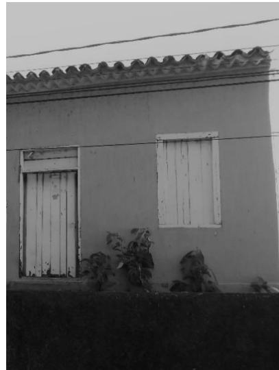
Figura 2 - Edificações com Beiral de Beira-Seveira, em um trecho da Rua Praça do Rosário. Fonte: Os Autores, 2019.
