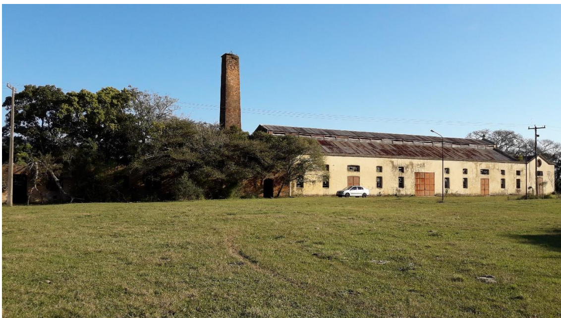
Figura 1 - Edificações da Charqueada Paredão, Cachoeira do Sul - RS. Fonte: fotografia de Leonardo I. G. de Franceschi, 18 de agosto de 2018.
