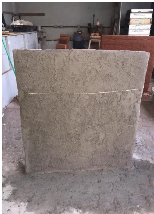
Figura 2 - Parede finalizada com vidro moído como substituição do pó de mica, Conjunto II da Universidade Franciscana, Santa Maria – RS.
