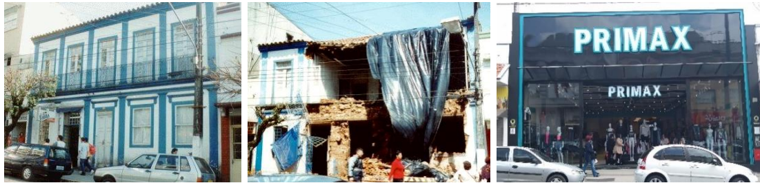
Figura 2 - Sobrado do século XIX que se encontrava em processo de tombamento e ruiu em 2000, após ação criminosa, e edificação posterior voltada ao comércio que foi erguida em seu lote.
