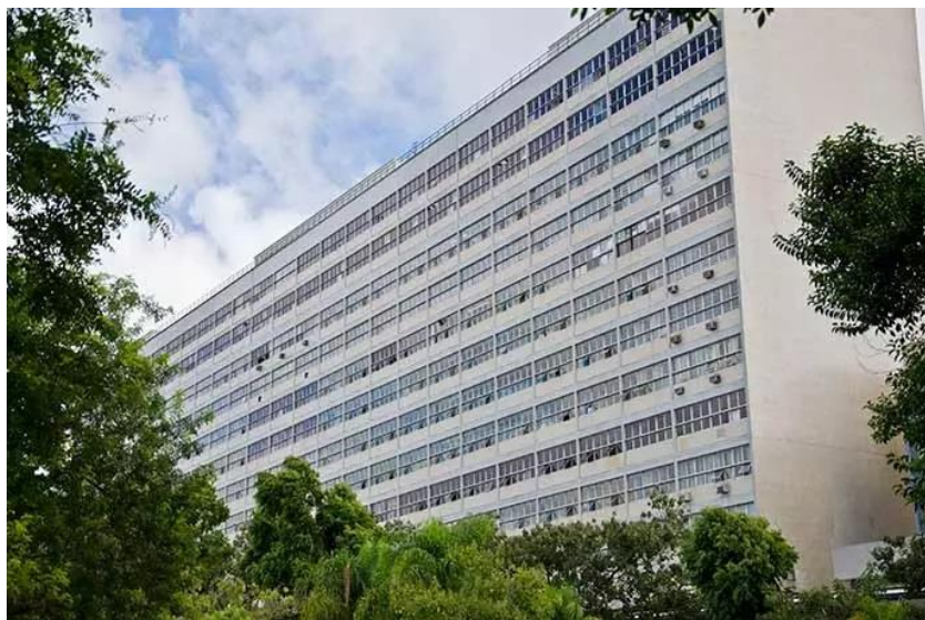
Figura 2 - Hospital de Clínicas, Porto Alegre - RS. Fonte: Clovis S. Prates
