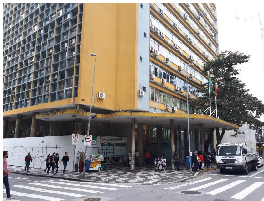
Figura 1 - Esquina Edifício das Diretorias, centro de Florianópolis- SC. Fonte: fotografia de Anna Pimenta, 22 de julho de 2019.
