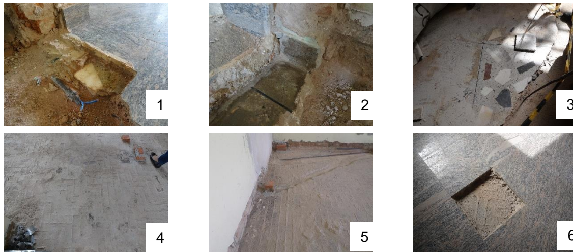
Figura 2 - Prospecções arquitetônicas: o uso de piso em granitina (1, 2 e 3) e taco de madeira (4, 5 e 6). Fonte: Acervo fotográfico IPHAN-GO.
