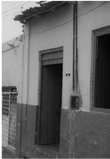
Figura 1 - Edificações com Beiral de Cachorro, em um trecho da Rua Praça do Rosário. Fonte: Os Autores, 2019.
