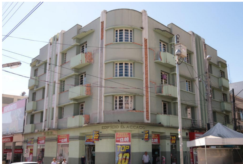
Figura 3 - Edifício Dr. Accacio, importante exemplar do estilo Art Déco em Lages, estava em processo de tombamento municipal, quando o proprietário recorreu e ganhou em primeira instância. Fonte: fotografia de Camila Paes/Jornal Correio Lageano, 2018.
