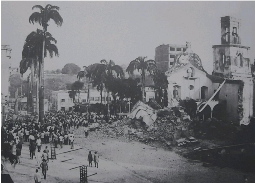
Figura 4 - Demolição da Catedral Barroca para construir a nova Catedral, em 1968. Fonte: FREIRE, 1997.
