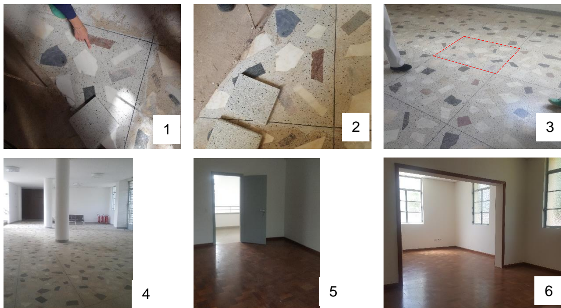
Figura 3 - (1) e (2) remanescente de piso em granitina com cacos, encontrados no saguão do edifício. (3) (4) (5) e (6) recomposição pisos em granitina com cacos e piso tablado de madeira, conforme paginações encontradas nas prospecções realizadas no edifício.
