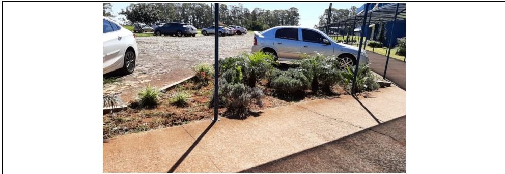
Figura 8: Situação atual do Prédio 2 da UFSM-PM
