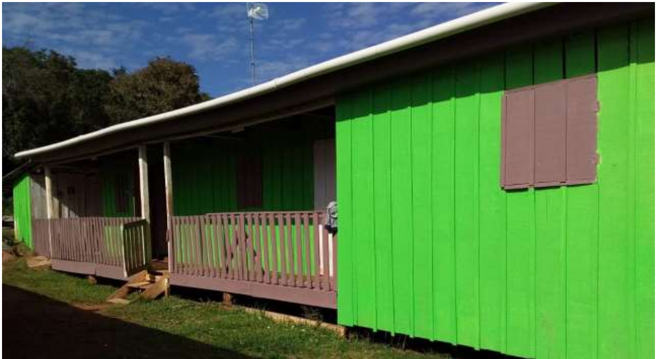
Figura 2 – Um dos dois espaços construídos da escola Kaingang
