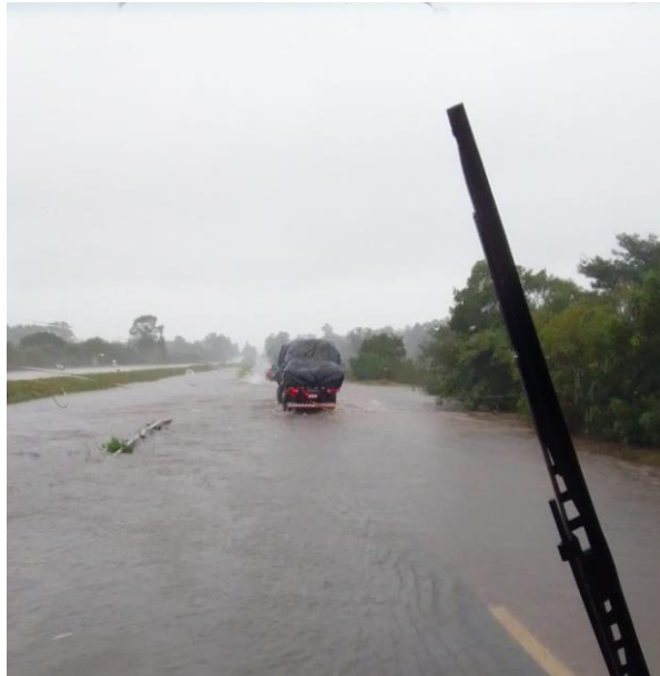
Figura 6 – Exemplo de estrada bloqueada devido influência da água em áreas planas com dificuldades de escoamento
