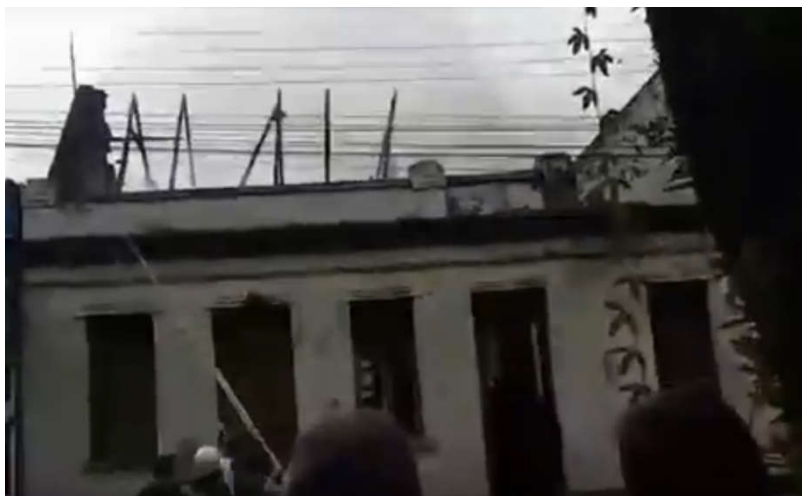
Figura 38 – Incêndio, Hotel do Comércio
