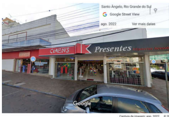
Figura 15 - Edificação construída em lugar do Cine Theatro Municipal
