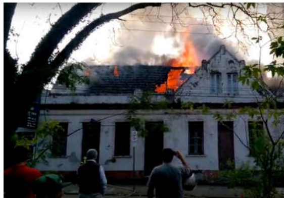
Figura 34 – Incêndio, Hotel do Comércio
