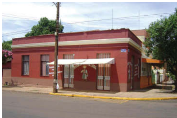
Figura 46 - Edifício Rodeio das Pilchas
