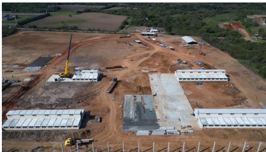
Figura 49 – Imagem aérea do canteiro de obra
