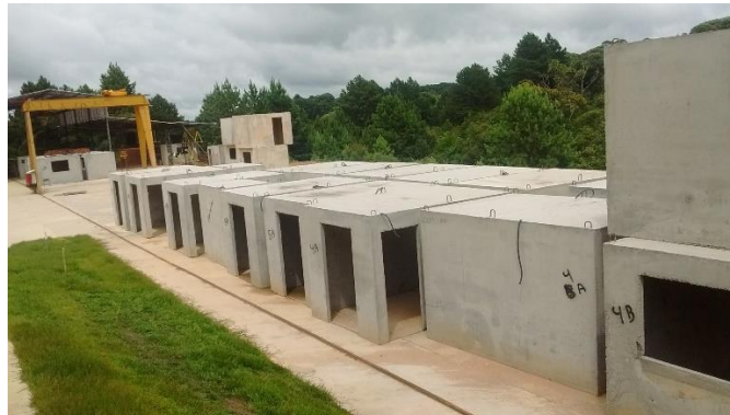
Figura 36 – Construção em blocos celulares de concreto armado
