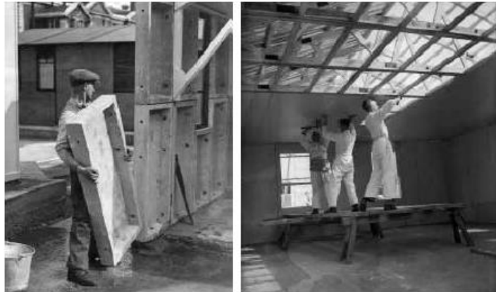
Figura 6 – Montagem de uma edificação de madeira
