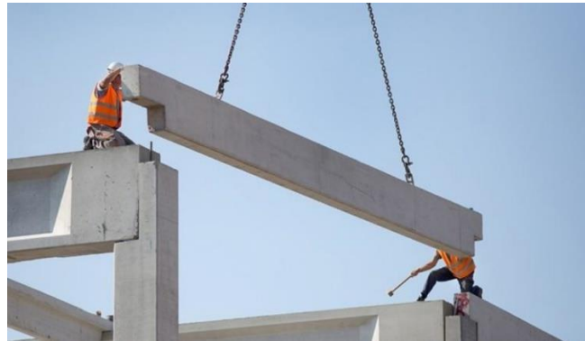
Figura 37 – Situação transitória de projeto, manuseio e içamento
