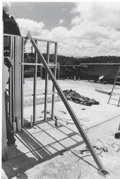
Figura 30 – Ancoragem provisória do painel em Light Steel Frame
