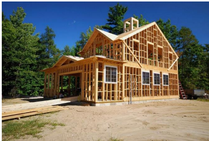
Figura 38 – Edificação em Wood Framing
