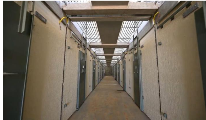
Figura 47 – Estrutura da Penitenciária Charqueadas II quase finalizada
