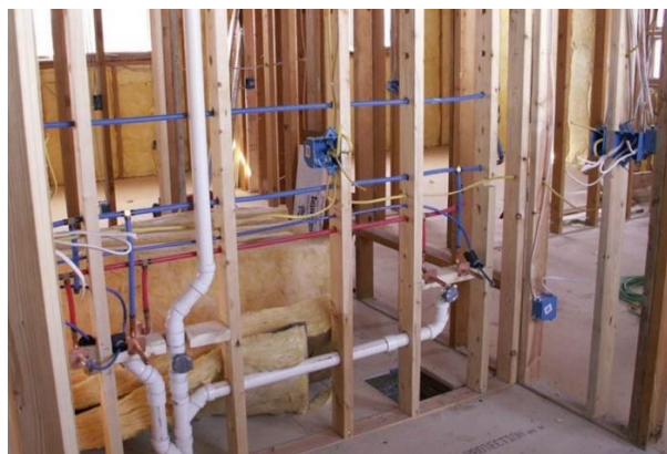
Figura 42 – Embutimento de instalações no interior de painéis em wood frame
