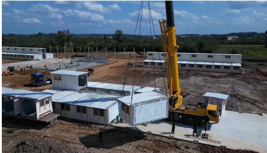
Figura 48 – Içamento de um módulo em local de obra
