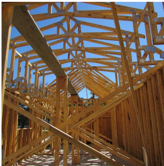
Figura 43 – Cobertura de uma edificação em wood frame
