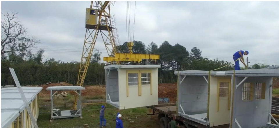
Figura 47 – Preparação para o transporte dos módulos
