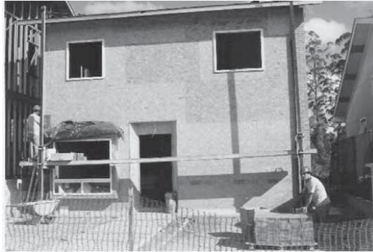
Figura 24 – Fechamento de uma residência com painéis OSB
