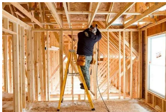
Figura 41 – Painéis de madeira no sistema Wood framing
