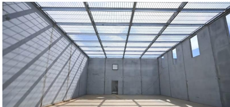
Figura 51 – Fechamento das áreas coletivas com grades metálicas
