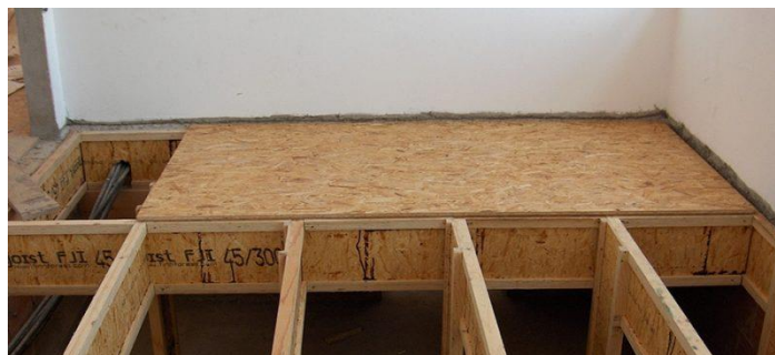
Figura 40 – Deck formado com chapas de OSB apoiado em vigas de madeira
