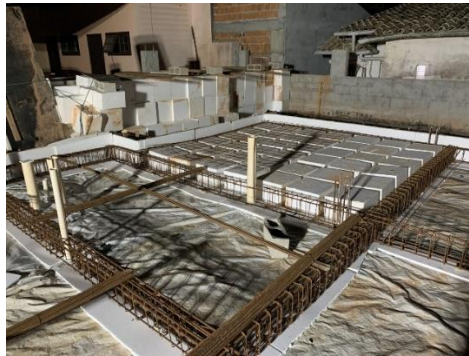
Figura 39 – Fundação sendo executada para receber wood frame
