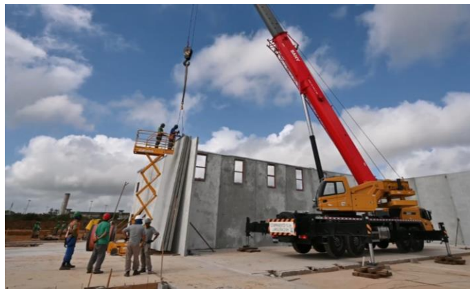
Figura 50 – Montagem das paredes do Centro Administrativo
