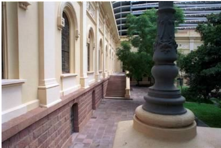
Figura 3 – Prédio em "L", fachada
