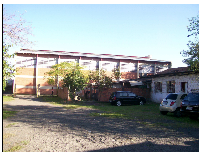
Figura 4 – Ginásio da Escola Municipal de Ensino Fundamental Professor Tiago Würth
