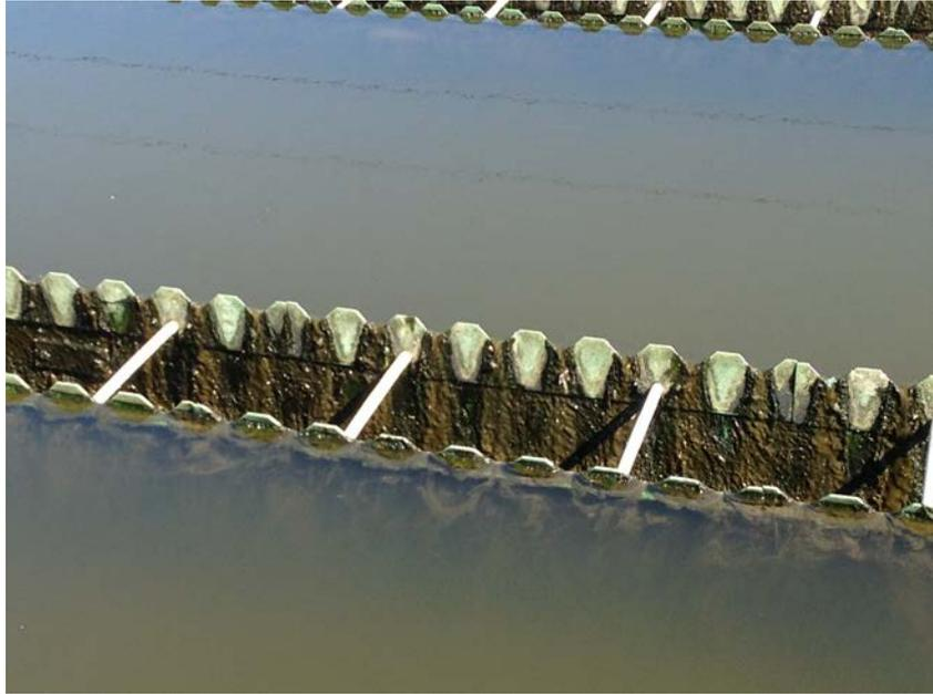
**Foto 8.1:** Decantador de escoamento da água.
