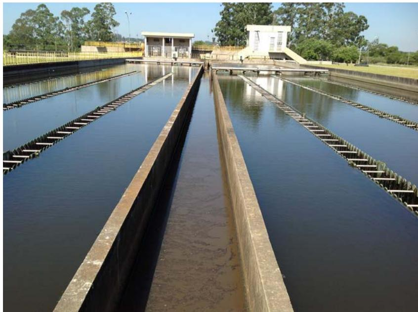
**Foto 8.2:** Foto frontal dos decantadores com o canal central de lodo residual.
