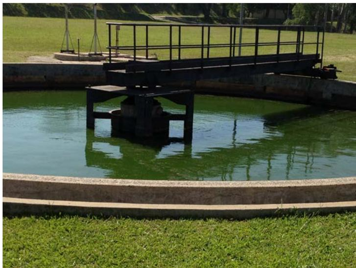
**Foto 7:** Adensador para compactação do lodo.
