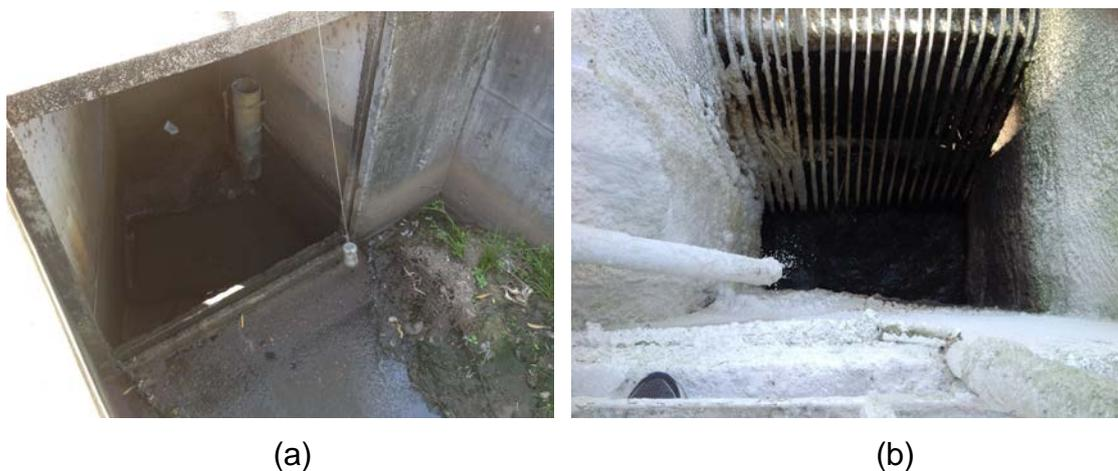
**Foto 1:** (a) Entrada do esgoto na ETE. (b) Grade de proteção.
