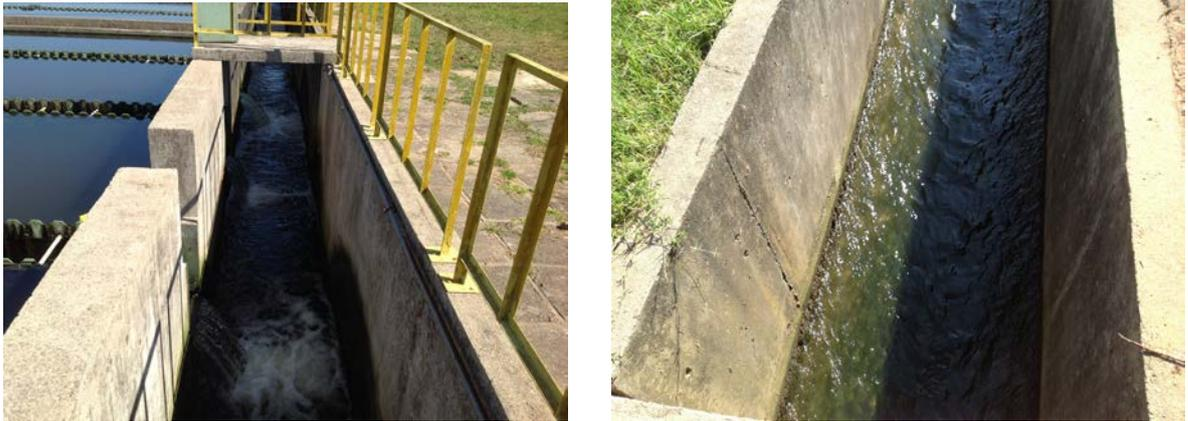
**Foto 8.3:** Água pós-tratamento saindo do decantador e retornando a fonte.
