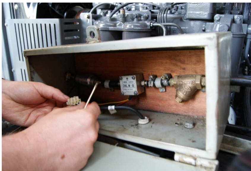
Figura 64 - Instalação do fluxômetro para determinação do consumo de combustível.
