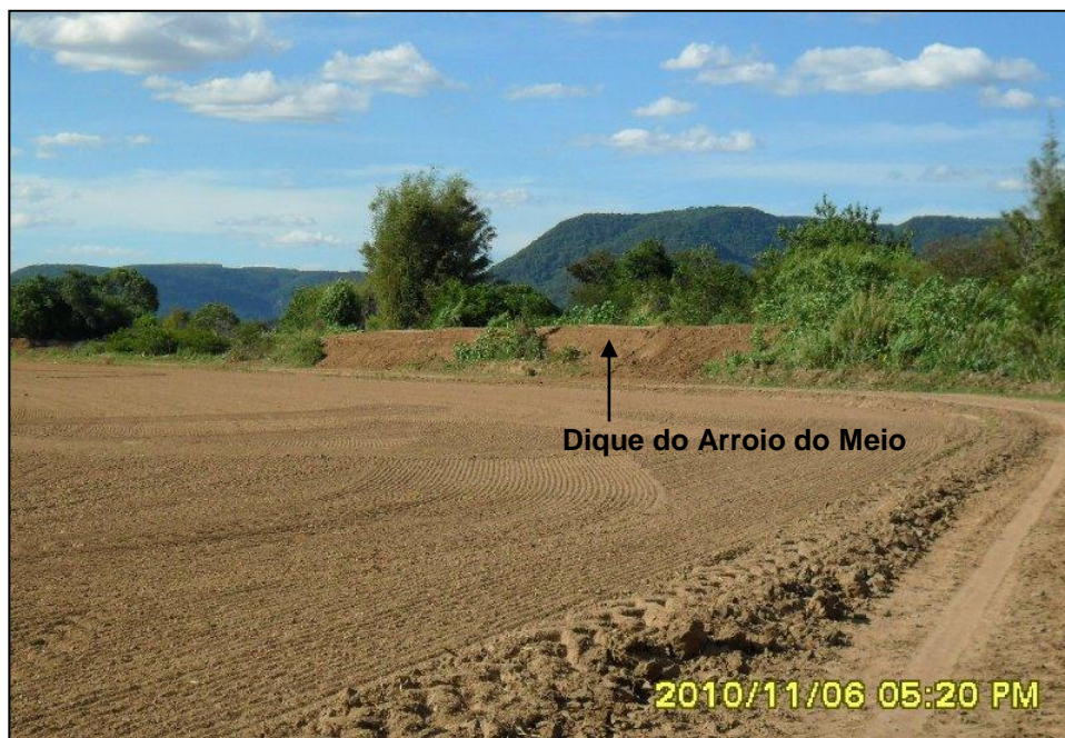
Figura 28 – Dique construído para evitar o extravasamento do Arroio do Meio. Fonte: Acervo do autor. Data da foto: 06/11/2010.
