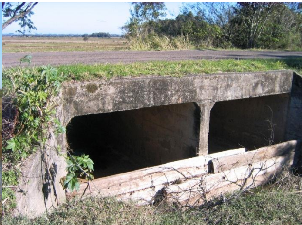
Galeria na ERS-511 (IRM 1), obstruída para reter a água à montante. Foto: Alessandro Miola (23/07/2010).
