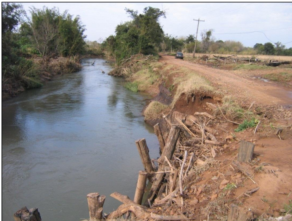
Figura 27 – Desmoronamento de margem originado por processo erosivo causado por uma cheia, sobre a margem do Arroio Grande, tangenciando uma estrada rural. Fonte: Acervo do autor. Data da foto: 26/10/2011.
