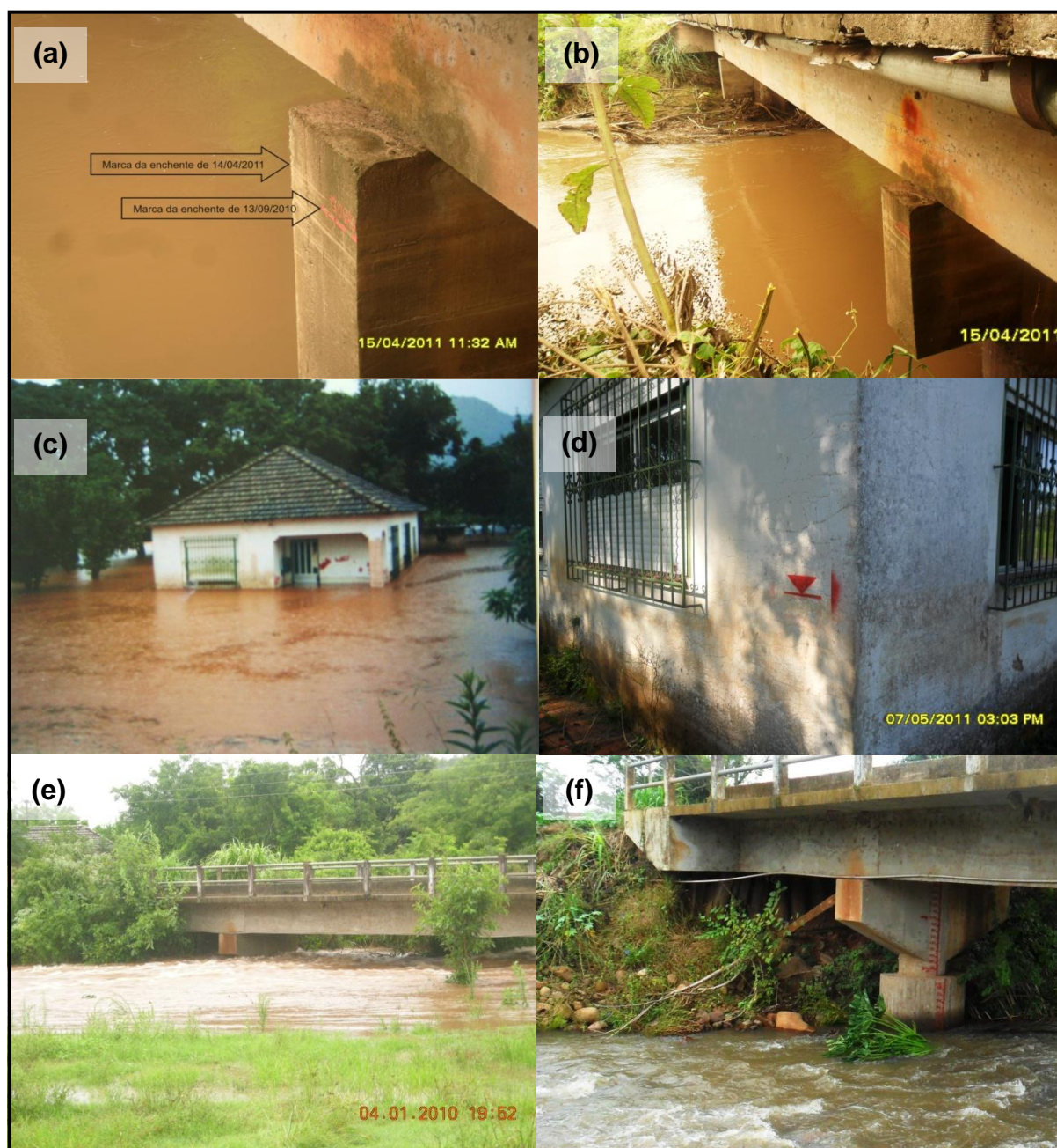
Figura 35 – Mosaico de fotos com exemplos de marcas de enchentes: (a) e (b) – Ponte da ERS511 no Arroio do Meio (14/09/2010 e 15/04/2011); (c) e (d) – Residência na várzea do Arroio do Veado (07/01/2001 e 04/01/2010); (e) e (f) – Ponte da Estrada de Três Barras no Arroio Manoel Alves (04/01/2010 e 15/04/2011). Fonte: Fotos ‘a’, ‘b’, ‘d’ e ‘f’ de Alessandro C. Miola; Foto ‘c’ de Júlio Noal; e Foto ‘e’ de Rafael Dalla Lana.
