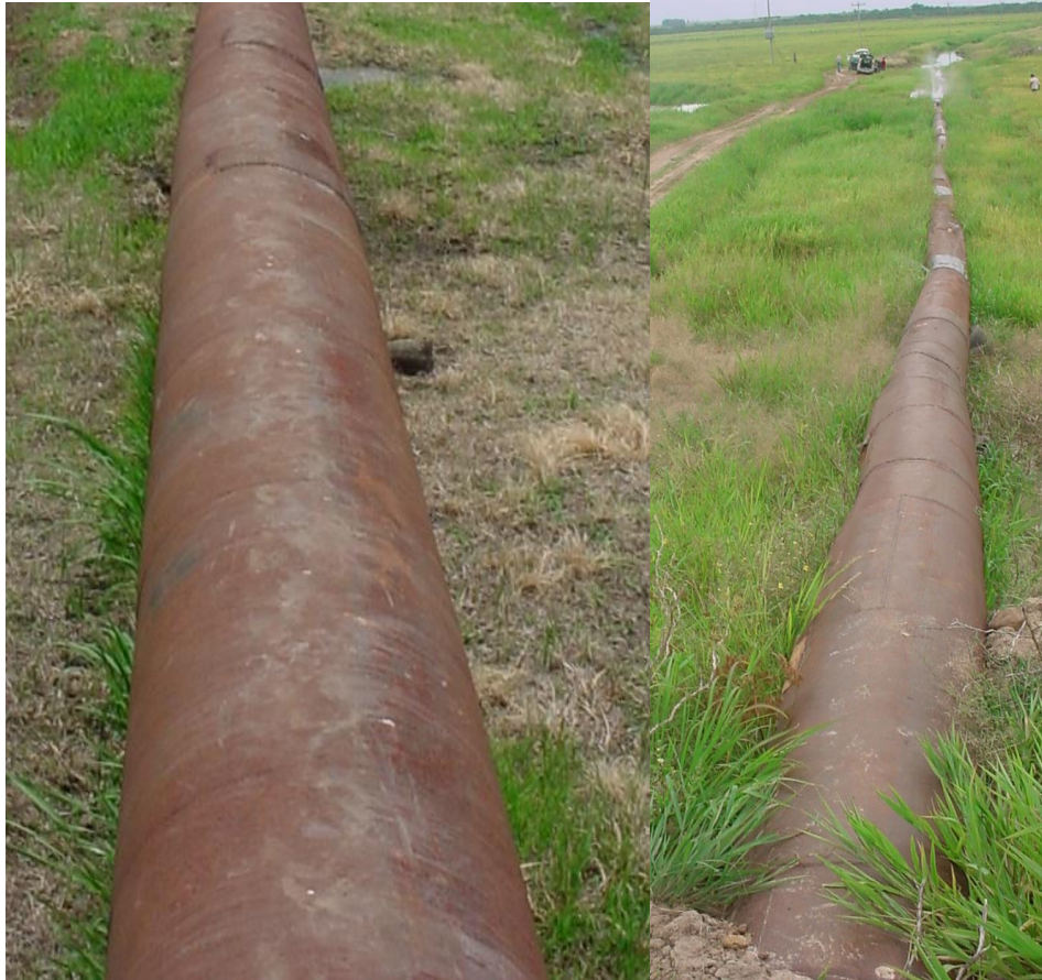
Figura 3. Aspecto da tubulação de aço soldado usada nas lavouras de arroz.
