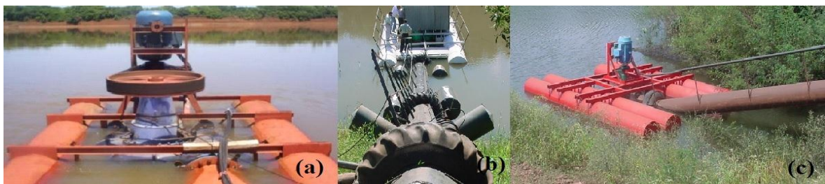
Figura 6. Estruturas flutuantes para sustentação de estações de bombeamento. (a) vista do posicionamento da bomba, (b) vista da junta de dilatação na tubulação de recalque, (c) vista de acoplamento direto entre bomba e motor.
