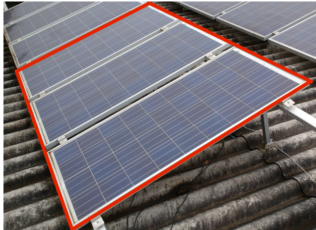
Figura 73 – Protótipo desenvolvido para obter dados de tensão e corrente dos três arranjos fotovoltaicos
