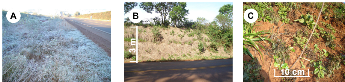
Figura 23 – Ocorrência de geada (A), vegetação seca pela geada (B) e efeito de geada em revegetação natural após queimada em talude rodoviário (C), Cruz Alta, RS, Brasil (2009).
