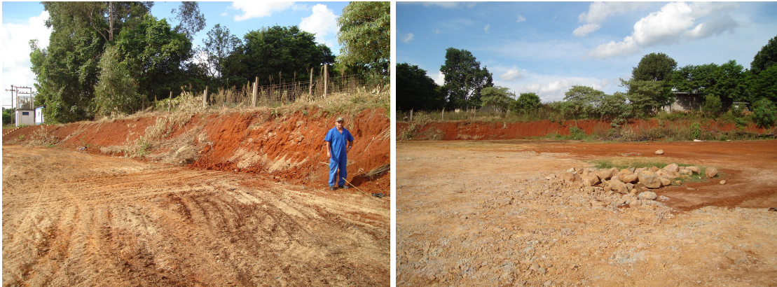
Figura 10 – Área de talude em latossolo antes da implantação do experimento, Cruz Alta, RS, 2010.
