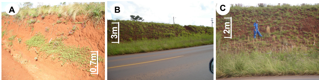
Figura 22 – Cobertura vegetal em taludes de estrada (A) e rodovias (B e C). Talude revegetado com Brachiaria spp. há mais de 20 anos (B e C). Pode-se observar a ocorrência da invasora Eragrostis plana (capim-anoni) junto à base dos taludes rodoviários. Cruz Alta, RS, Brasil (2009).
