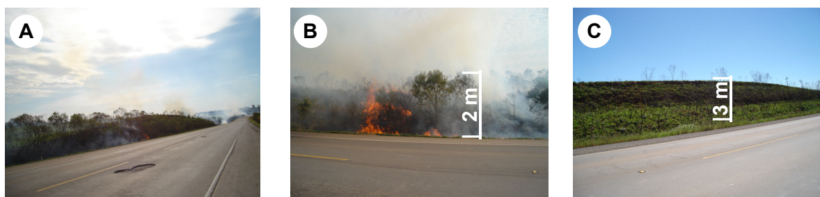
Figura 24 – Queimada em talude rodoviário (A e B) e regeneração da vegetação (C). Pode-se observar na foto “A”, três focos equidistantes, o que caracteriza queimada intencional criminosa. Pode-se perceber, na foto “C”, mudança da geometria do talude devido a erosão superficial, com deposição de solo em sua base. Cruz Alta, RS, Brasil (2009).
