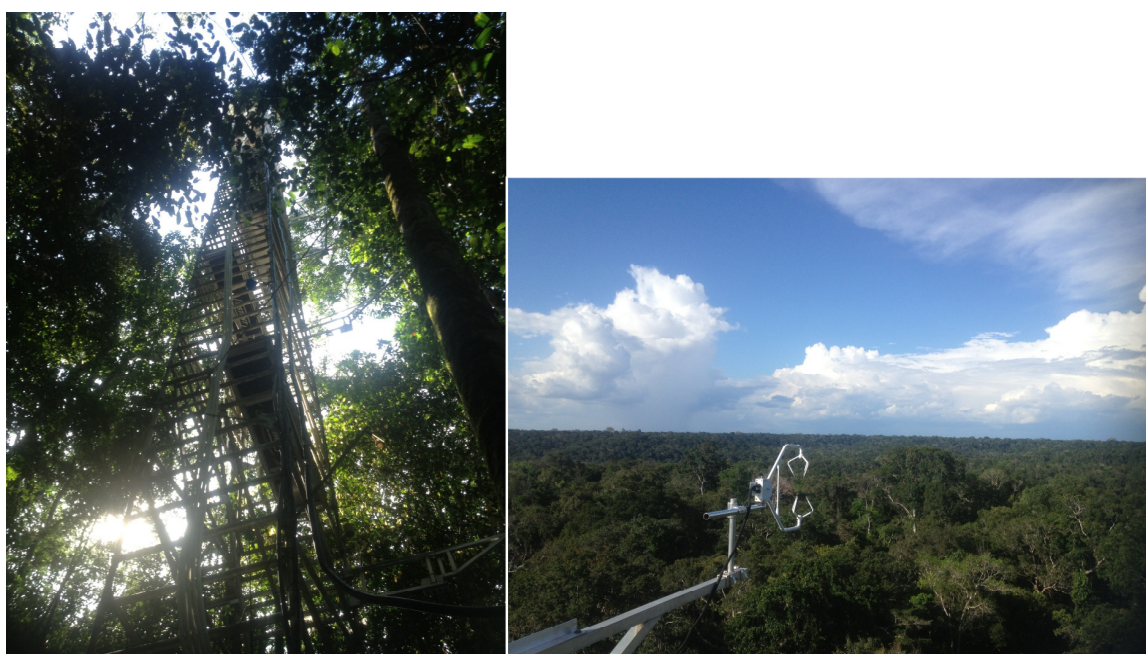
Figura 3.1 – Torre do sítio Cuieiras – INPA, batizada de K34 (imagem da esquerda). Disposição de um dos sensores CSAT 3 instalados ao longo da torre (imagem à direita).
