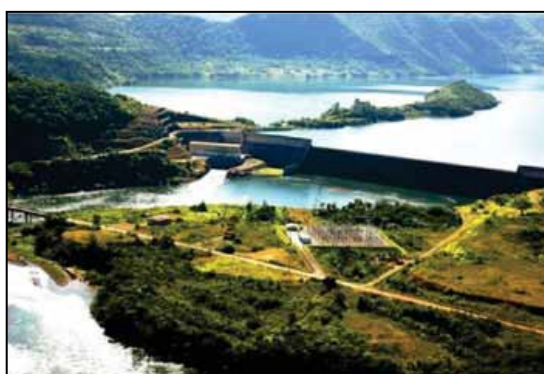
Figura 24: Usina Hidrelétrica de Dona Francisca. Fonte: Site Panorâmio.
