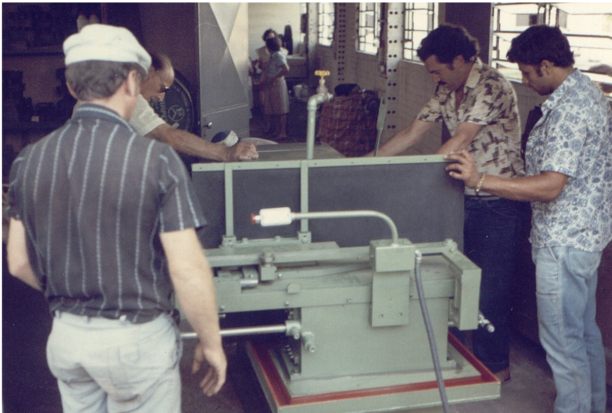
Figura 33 – Instalação da primeira vazadeira (máquina de fazer fio)
