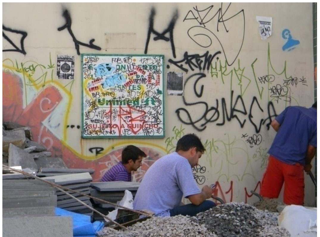
figuras 39 e 40_ Intervenções no prédio da Unimed de Santa Maria.
