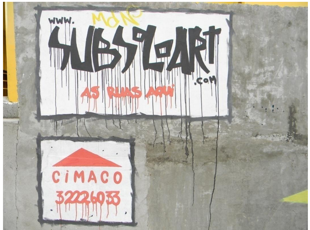
figura 48_ Assinatura SubSoloArt, projeto de intervenção no Viaduto da Avenida Rio Branco [-29.674779,-53.80904].
