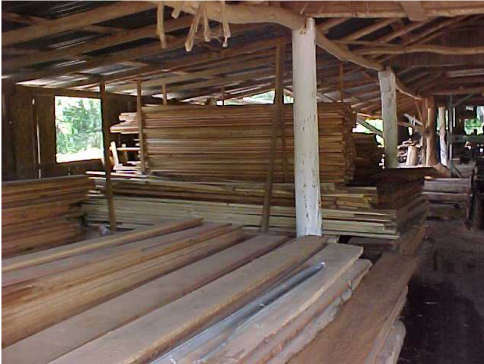
Figura 08 – Material próximo da lateral do prédio
