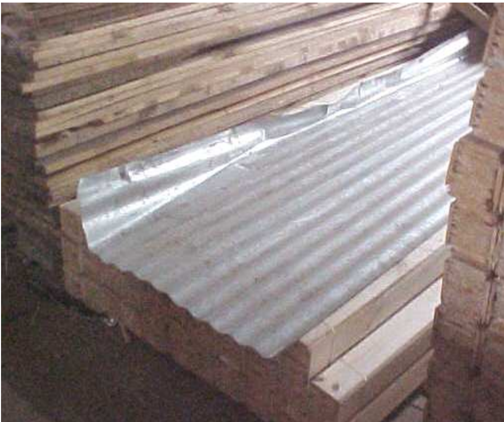
Figura 12 – Material cortante exposto na área de circulação
