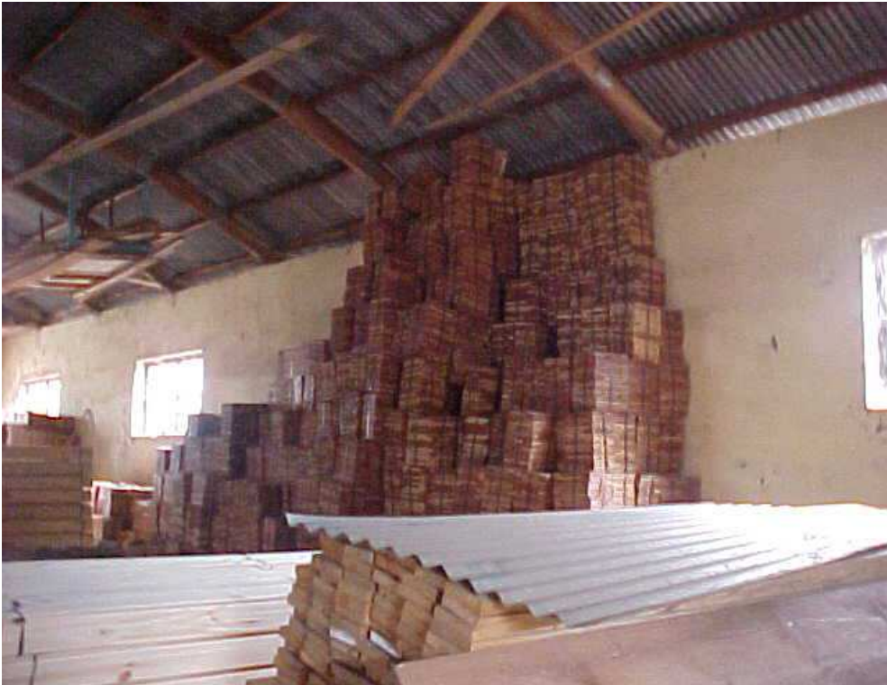
Figura 09 – Material empilhado inadequadamente
