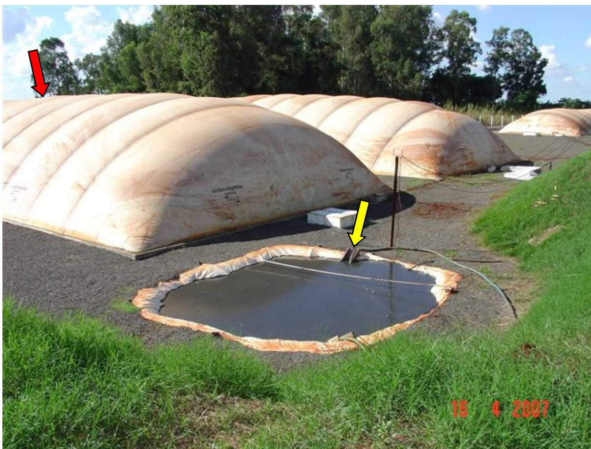
Figura 6 – Vista dos três biodigestores anaeróbicos em seqüência. Seta em vermelho indica o terceiro biodigestor, do qual sai o material para o tanque de coleta de efluentes (indicado pela seta em amarelo), onde foi coletada a primeira amostra.
