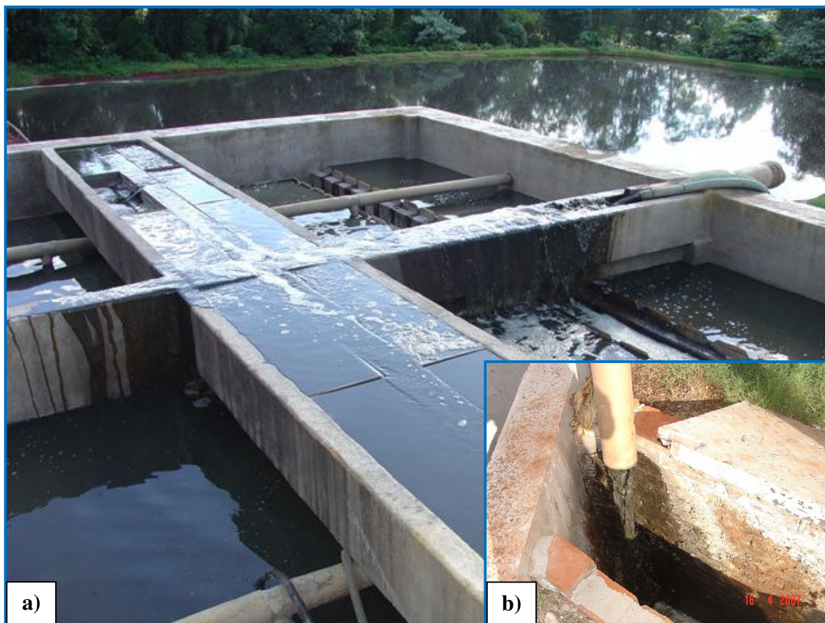
Figura 7 – Tanque de decantação do efluente de biodigestor (a) e detalhe da tubulação de saída (b), onde foi coletada a 2ª amostra de água residual da digestão anaeróbica de dejetos de suínos.
