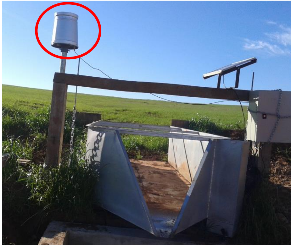
Figura 23 - Monitoramento da precipitação. Pluviógrafo
