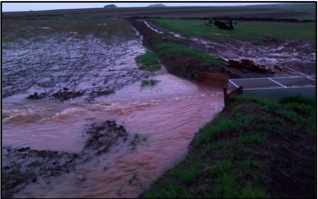
Fluxo entrada de água no vertedouro na bacia ST
