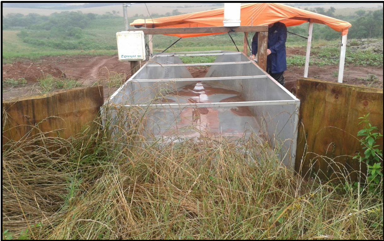
Vertedouro CT após evento do dia 03/11/2014.
