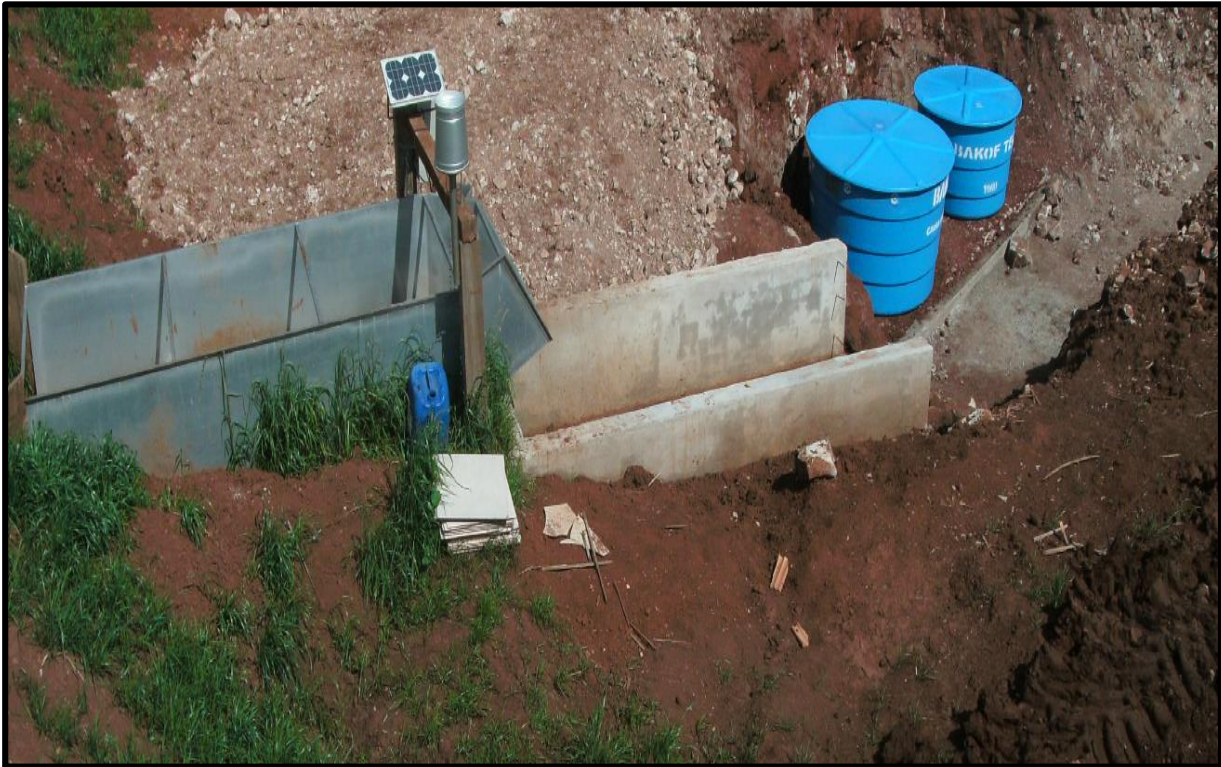
Estação de Monitoramento durante a construção.
