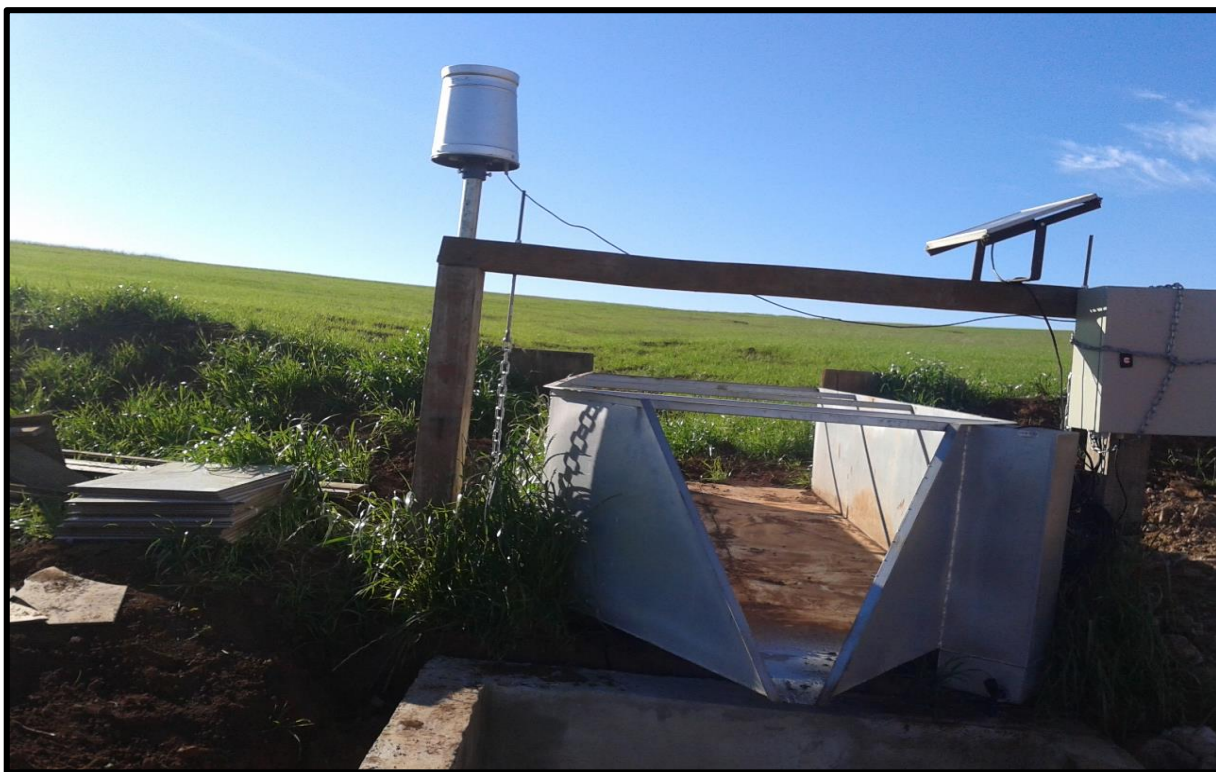
Vertedouro tipo H logo após um evento indicando o pluviógrafo, painel solar e caixa do datalogger.
