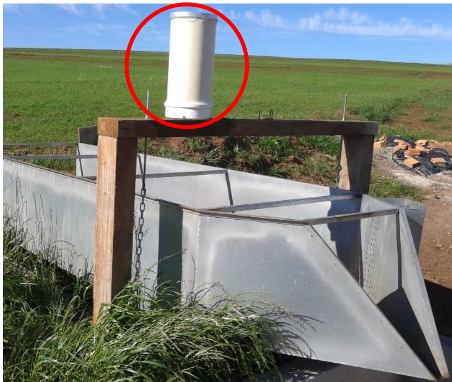
Figura 24 - Monitoramento da precipitação. Pluviômetro.
