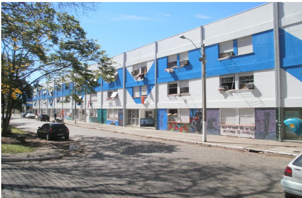
Imagem 36 – Prédio 1, pinturas da fachada em grafite, 2011.
