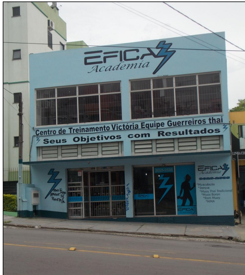
Figura 21 – Foto da fachada da Academia Eficaz.
