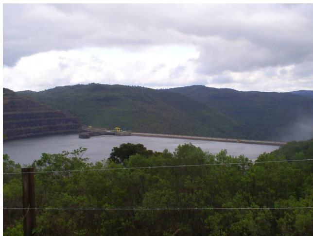
Figura 7 – Vista do barramento do rio Pelotas e início do lago da Usina Hidrelétrica Barra Grande.
