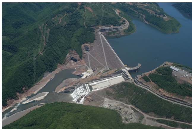
Figura 6 – Vista aérea da Usina Hidrelétrica Barra Grande (Vide créditos na lista de ilustrações).
