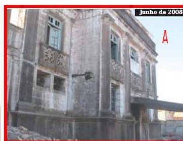
Mudanças no prédio que chegou a abrigar 285 presos em 1997 já podem ser percebidas na fachada, que ganhou novas cores
