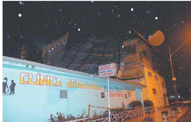
Vento de 70 km/h levantou o telhado de um prédio sobre uma clínica geriátrica em Porto Alegre
