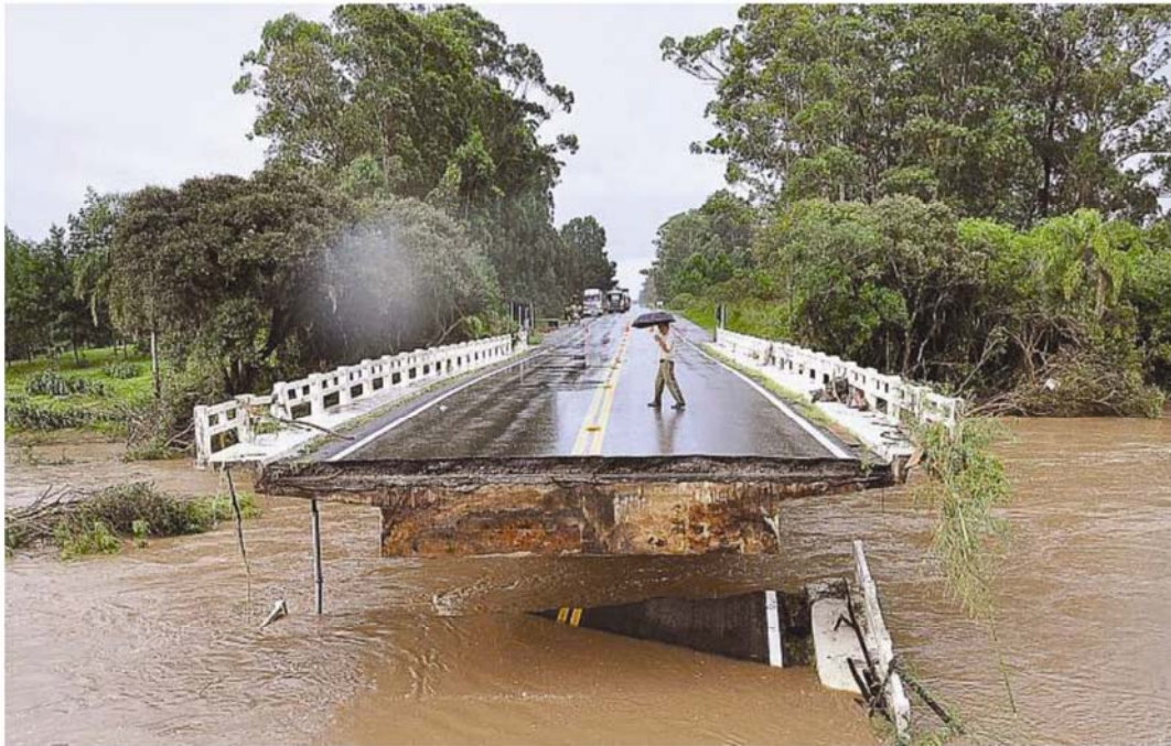
No km 468 da rodovia Porto Alegre-Pelotas (BR-116), a pista foi rasgada ao meio pela queda de uma das cabeceiras da ponte sobre o Arrolo do Pinto, levada pela água
