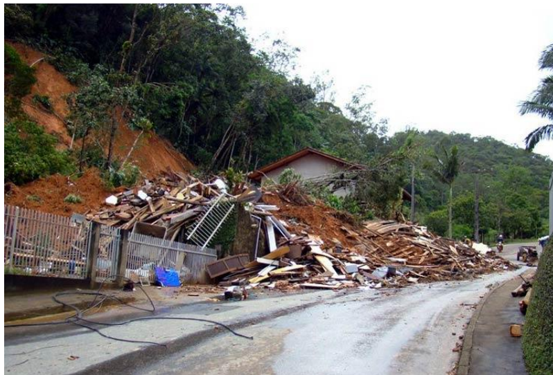
Figura 17– Desabamento de casa, obstruindo rua. Fonte: Jornal de Santa Catarina, 09/11/2009.
