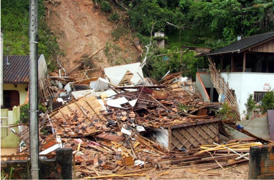
Figura12 – desmoronamento de casa no bairro Garcia em Blumenau. Fonte: Jornal de Santa Catarina, 09/11/2009.
