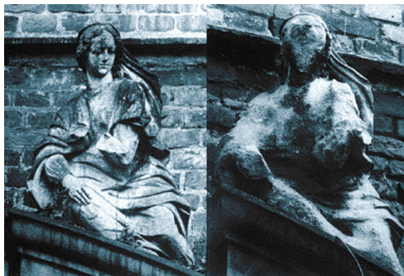
Figura 29 - Obra de arte a céu aberto 7
