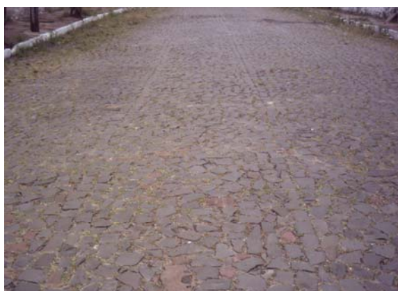
Figura 89 – Calçamento. Fonte: Idem figura 09.
