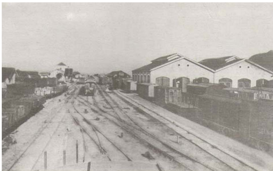
Figura 04: Oficinas da Viação Férrea. Fonte: Marchiori, (p.112, 1997)
