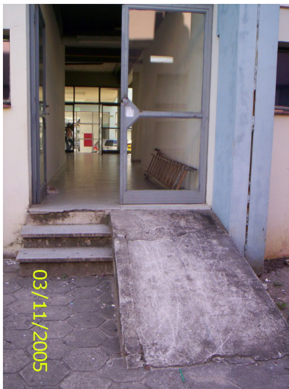
Figura 86 – Rampa de acesso ao prédio de Química – fundos – acesso restrito
