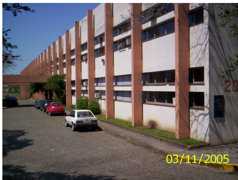
Figura 91 – Acesso ao Departamento de Sociologia/Patologia
