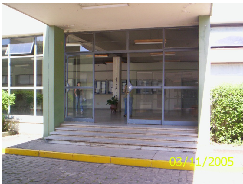
Figura 97 – Porta de acesso principal ao prédio do Departamento de Fisiologia e FACOS
