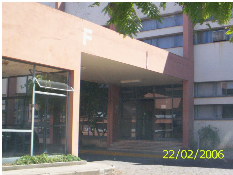
Figura 94 – Entrada principal do prédio do Departamento de Sociologia/Patologia
