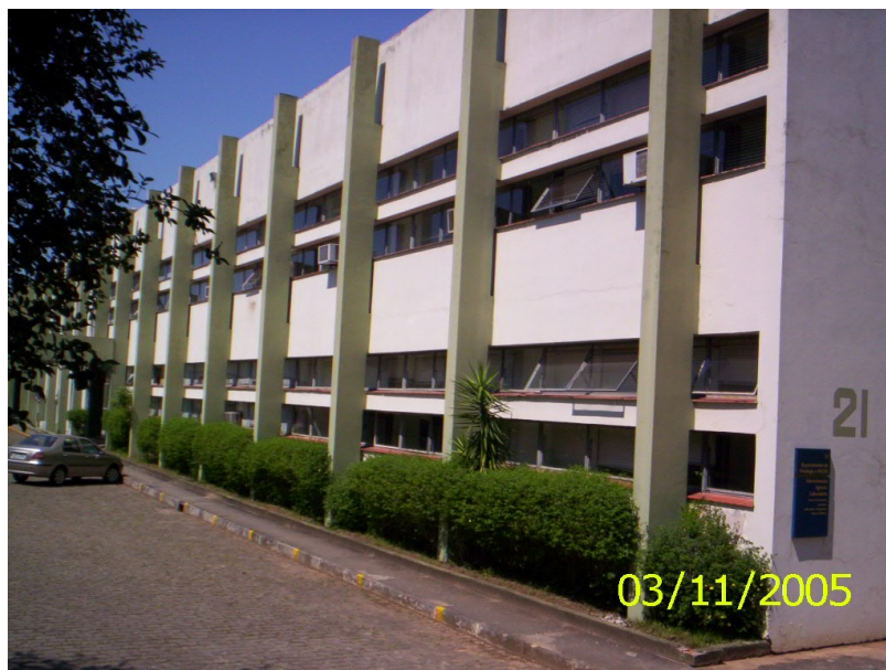
Figura 96 – Acesso ao prédio do Departamento de Fisiologia e FACOS
