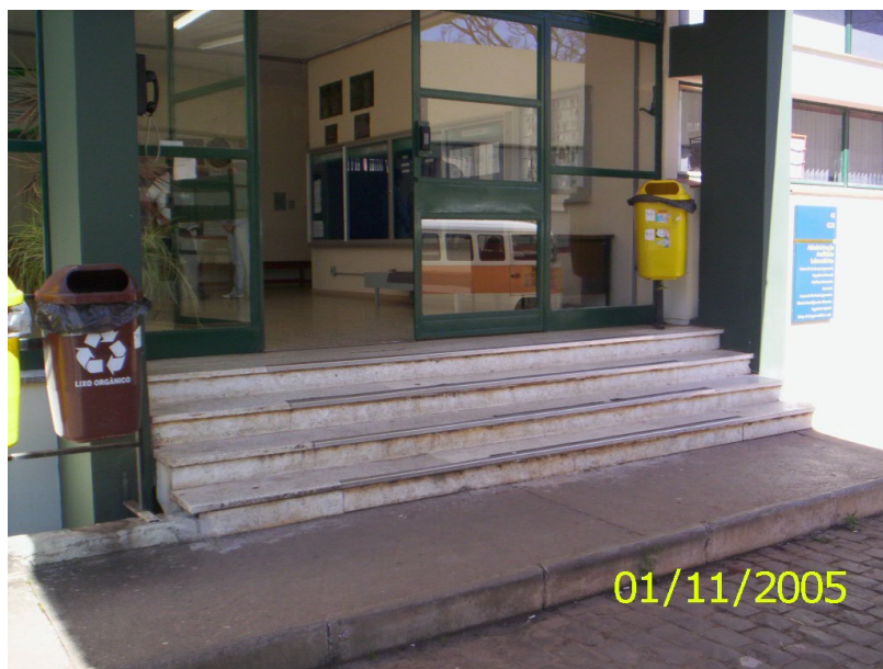
Figura 12 – Acesso ao CCR – Prédio 42
