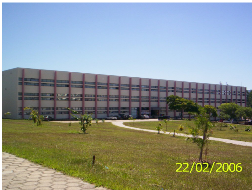
Figura 14 – Prédio de apoio ao CCR – Prédio 44
