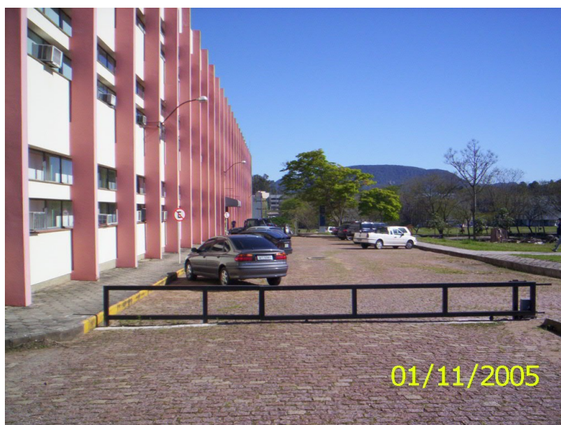
Figura 15 – Acesso ao prédio 44 – restrito
