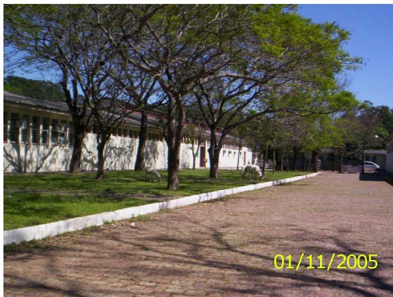
Figura 20 – Acesso lateral ao Hospital Veterinário
