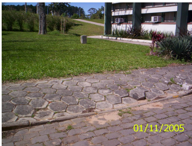
Figura 13 – Calçada de acesso ao CCR – Prédio 42
