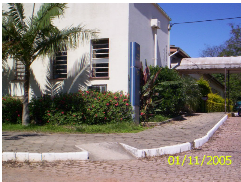
Figura 2 – Rampa de acesso ao Hospital Veterinário
