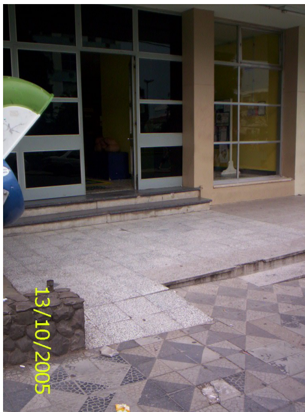
Figura 29 – Prédio da Unidade V – Centro de Ciências Sociais e Humanas (CCSH) – Centro
