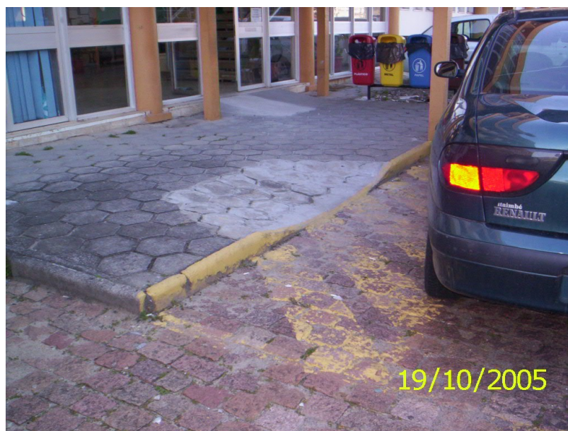
Figura 24 – Acesso ao CCS interrompido
