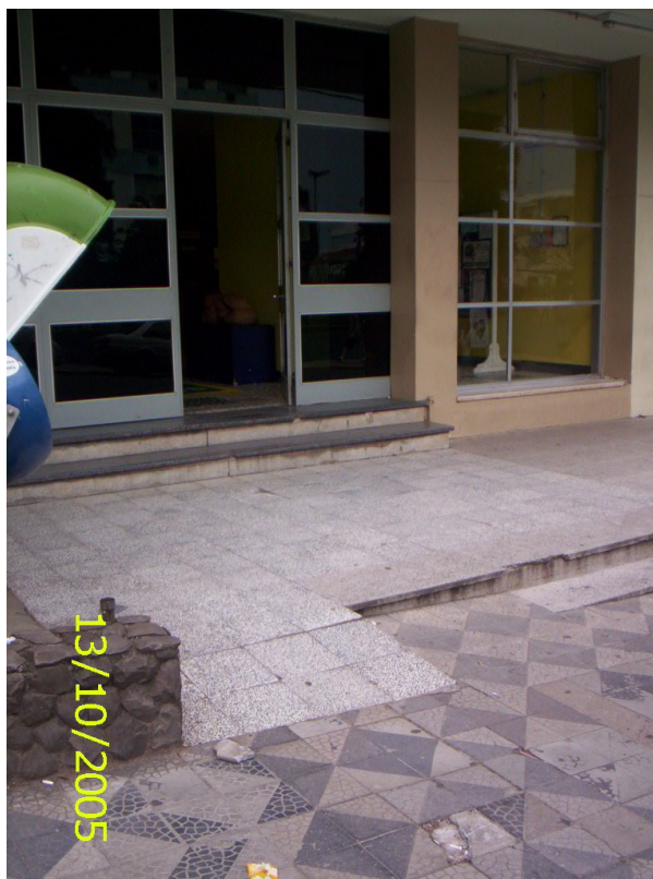
Figura 32 – Rampa de acesso ao prédio
