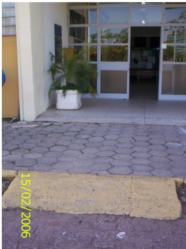
Figura 47 – Rampa de acesso ao CEFD deteriorada
