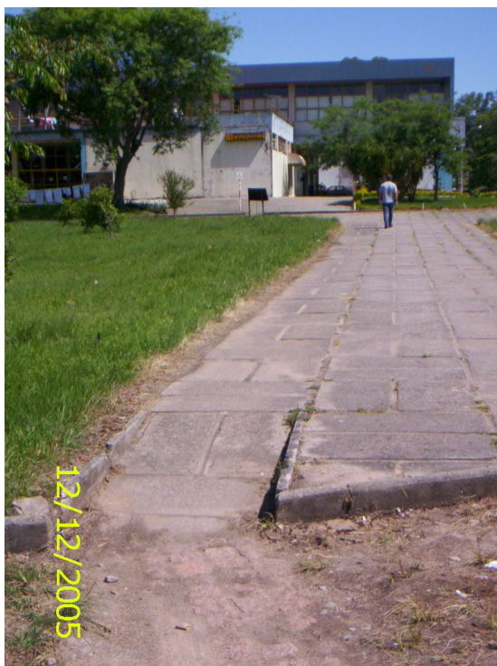
Figura 72 – Rampa de acesso ao Restaurante Universitário – UFSM
