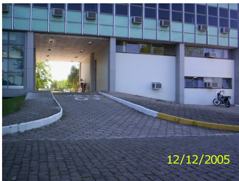
Figura 75 – Rampa de acesso da avenida principal à Reitoria
