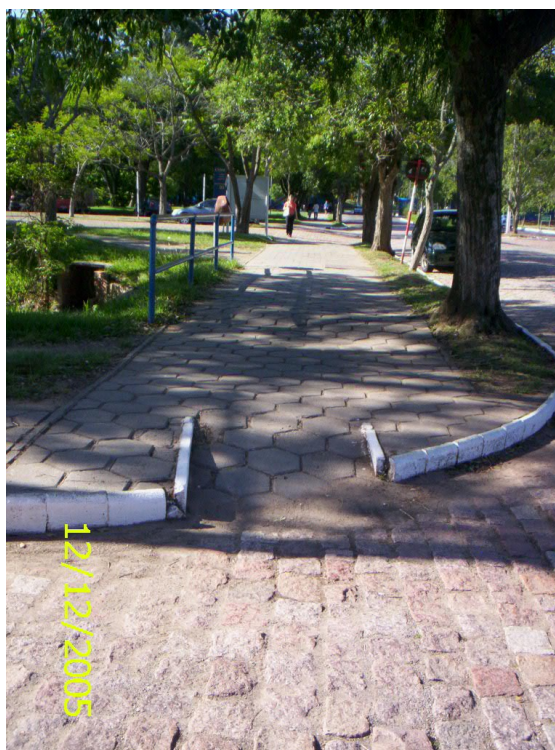
Figura 73 – Rampa de acesso aos prédios básicos – UFSM
