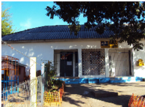
Figura 47: Escola Municipal de Ensino Fundamental João da Maia Braga – Localidade de Passo das Tropas, Distrito de Pains (Escola-Núcleo) Fonte: Arquivo GEPFICA
