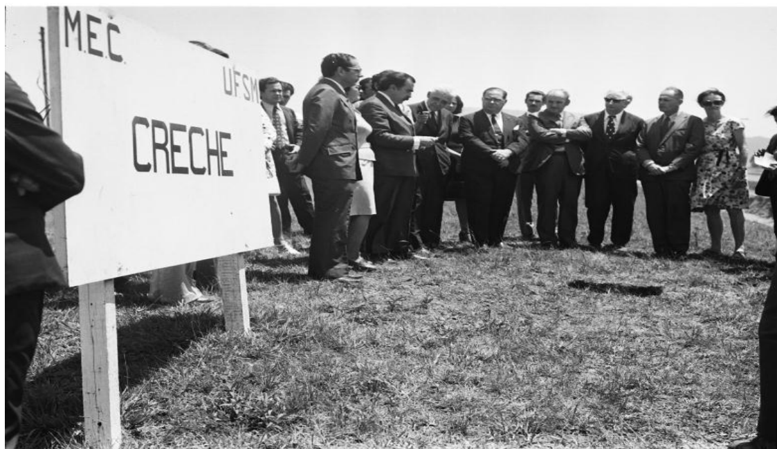
Figura 2-Lançamento da Pedra Fundamental da Creche em 18/12/1972- Fonte: DAG/Divisão de Arquivo Geral da UFSM
