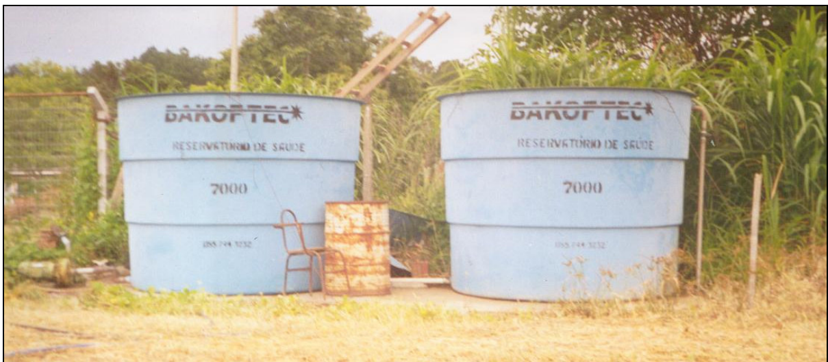
Figura 1. Reservatórios de água para irrigação, capacidade de 7000 L cada, área Experimental do Colégio Agrícola de Santa Maria. 2005, Santa Maria, RS.
