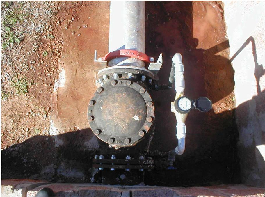
Figura 3.12 Medidor instalado na válvula de retenção da adutora de água.
