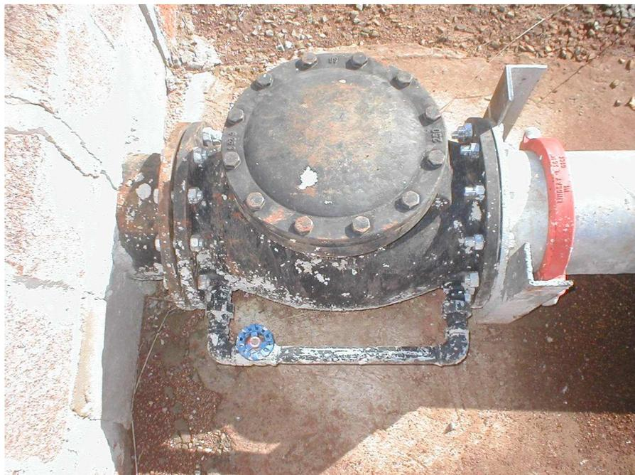
Figura 3.11 – Válvula de retenção utilizada como singularidade
