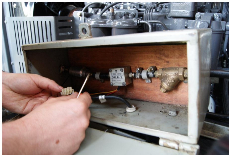
Figura 22 - Caixa de proteção e ligações do fluxômetro
