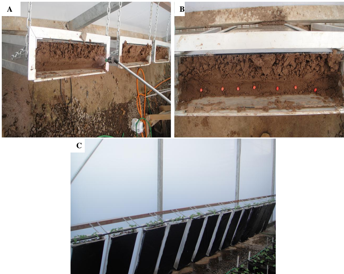
Figura 3 - Detalhamento da metodologia de instalação do ensaio em rizotron. Jato de pulverização durante a aplicação no sulco a 7 cm de profundidade (A). Deposição das sementes no sulco (B). Visão geral dos rizotrons já com as plantas emergidas e com sistema de fertirrigação instalado (C). Santa Maria, UFSM, 2012.
