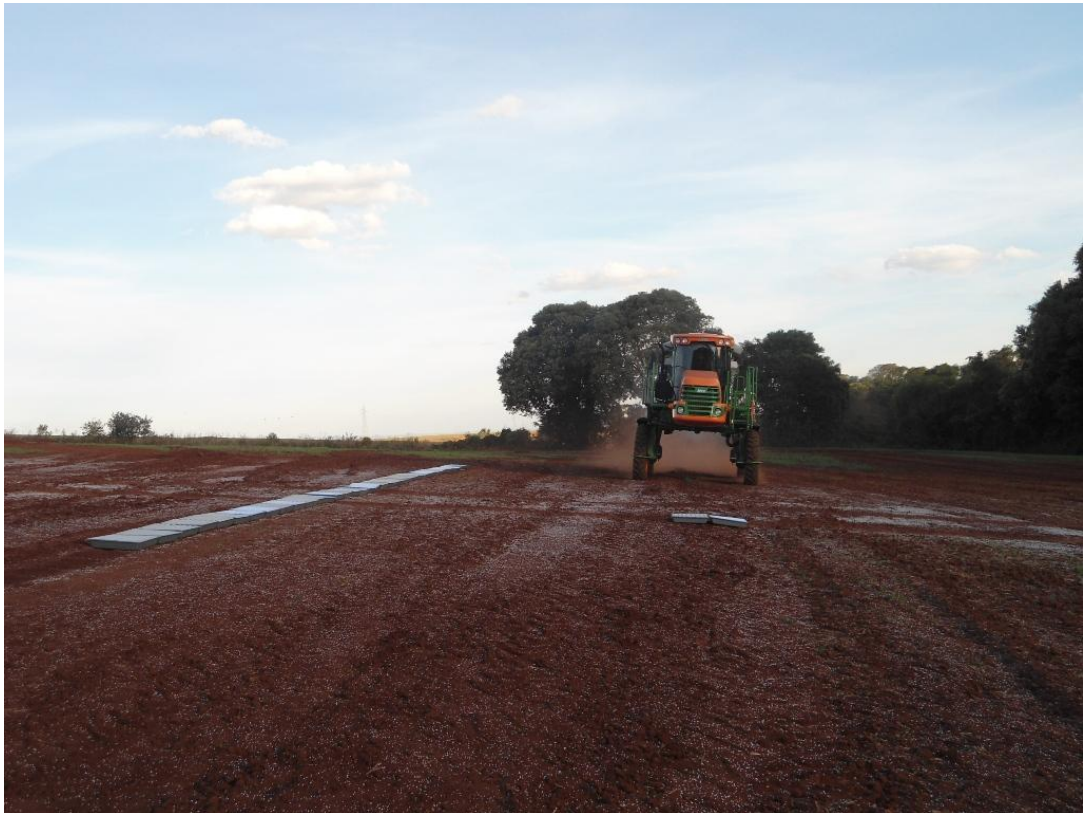
Figura 25 – Vista do distribuidor durante perfil longitudinal.
