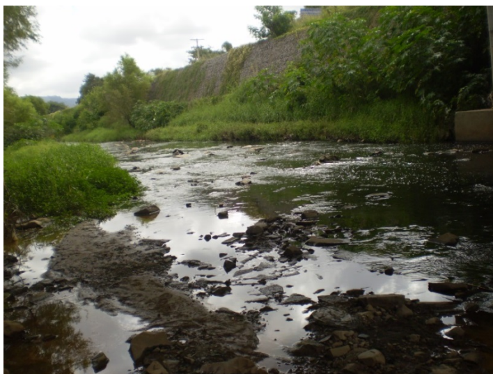
Figura 14. Enrocamento do leito no arroio Cadena.
