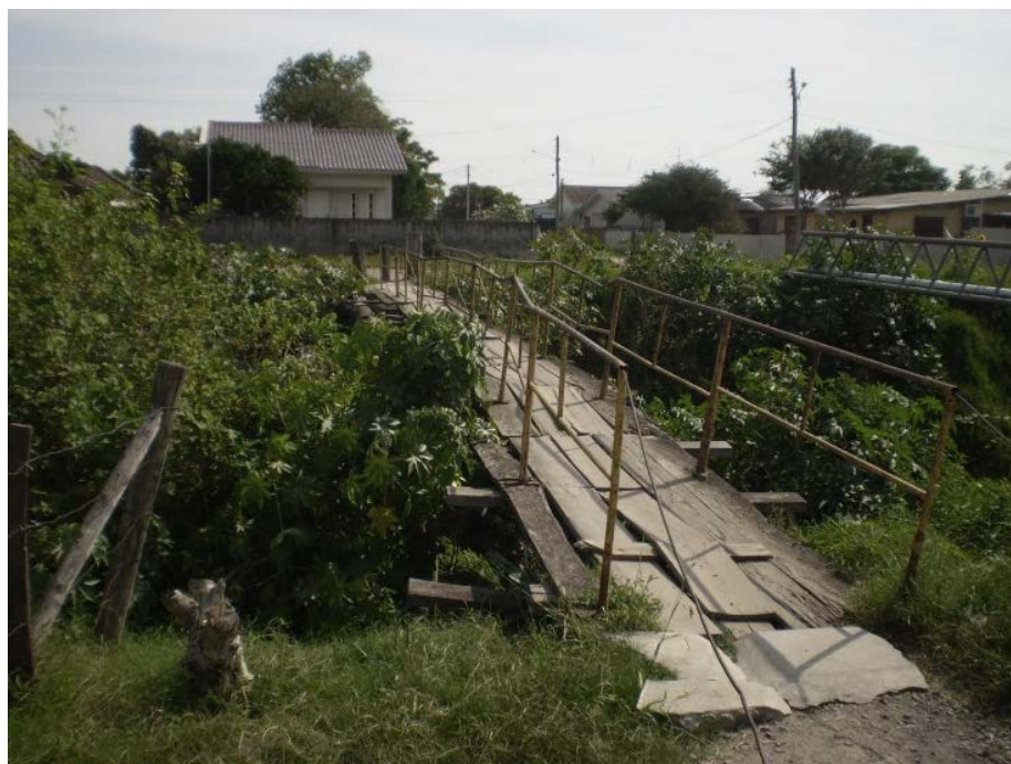
Figura 20. Ponte sobre a seção José Barin, no arroio Cadena.
