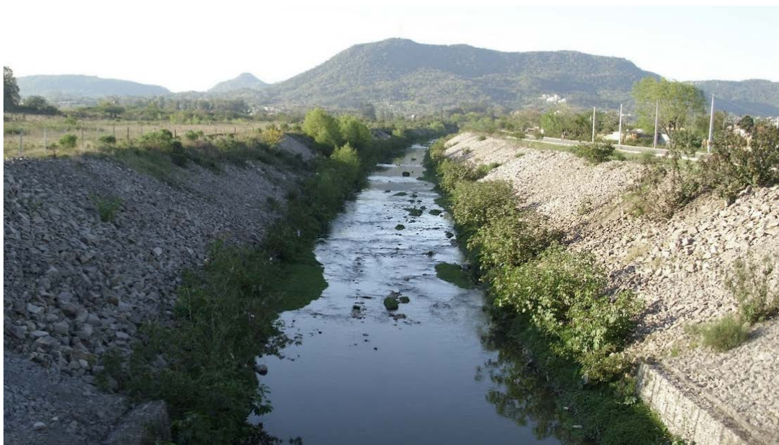
Figura 8. Cadena após o revestimento das margens.
