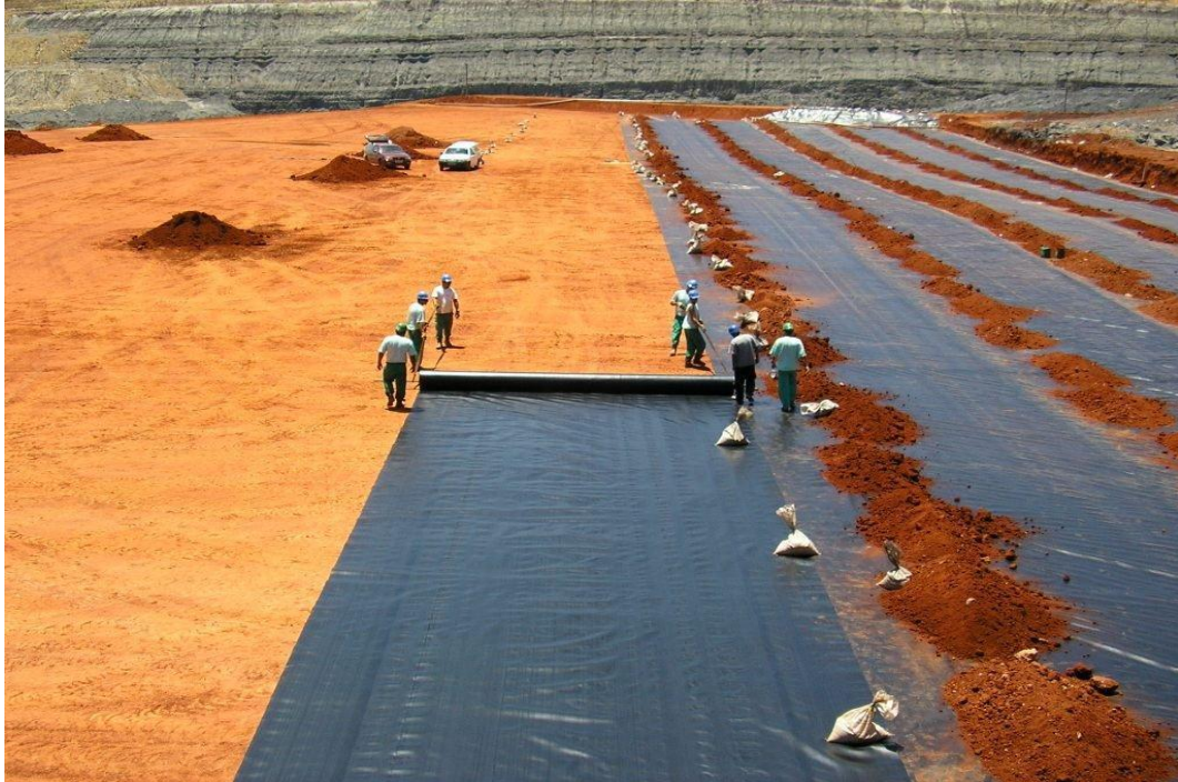
Figura 3.6 – Vista geral da instalação da geomembrana PEAD sobre a camada de argila compactada.
