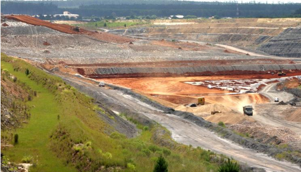
Figura 3.4 – Vista geral da área da Central de Resíduos de Recreio de Minas do Leão/RS.
