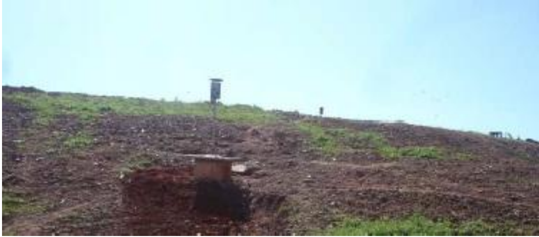
Figura 3.9 – Célula do aterro emergencial fase II de São Leopoldo em estágio final. Fonte: SCHOENELL, 2013.
