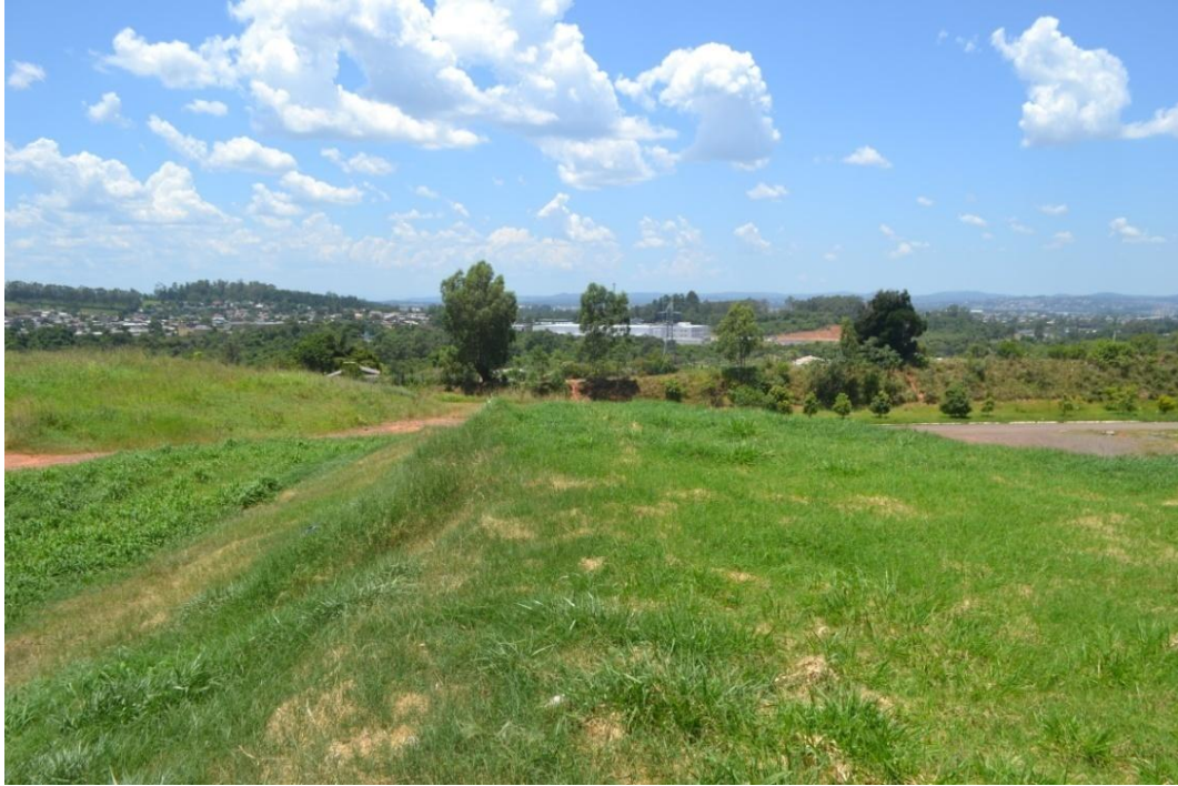
Figura 3.13 – Vista do Aterro Remediado de São Leopoldo encerrado. Fonte: do autor.
