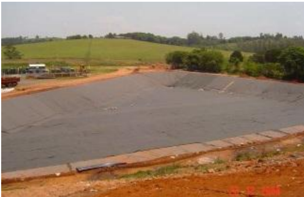
Figura 3.8 – Célula do aterro emergencial fase II de São Leopoldo em estágio inicial. Fonte: SCHOENELL, 2013.
