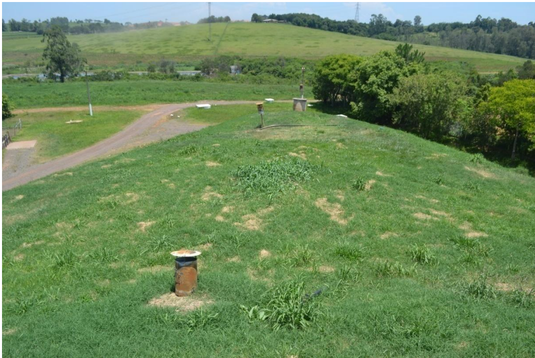
Figura 3.14 – Vista de cima do Aterro Emergencial Fase II de São Leopoldo encerrado. Fonte: do autor.
