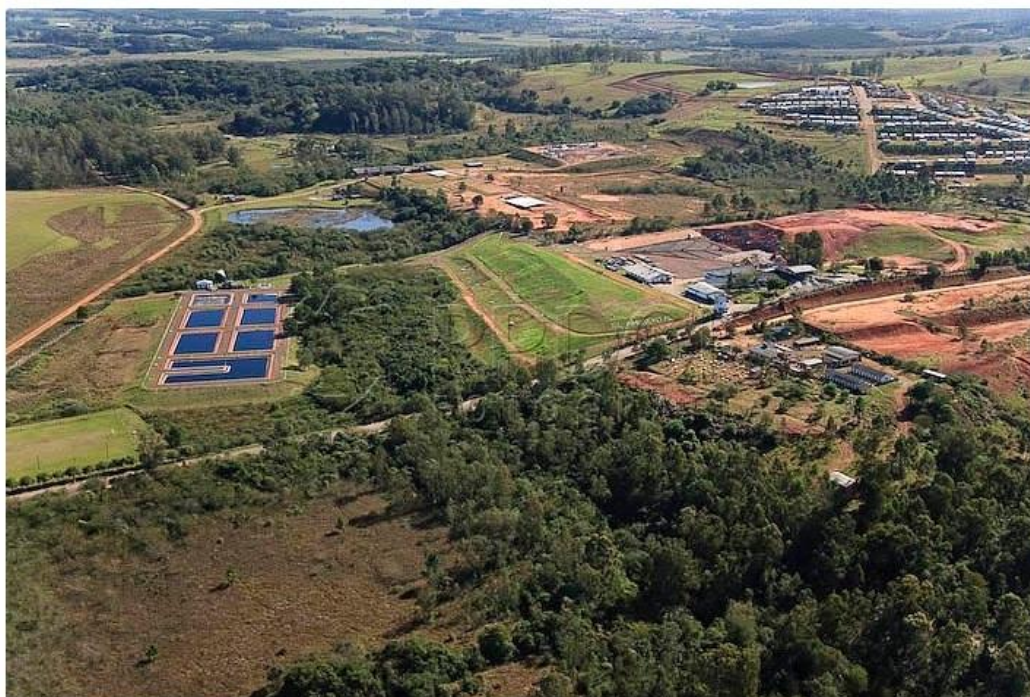
Figura 3.11 – Vista das células do aterro sanitário de São Leopoldo – RS. Fonte: Azambuja Engenharia e Geotecnia, 2011.
