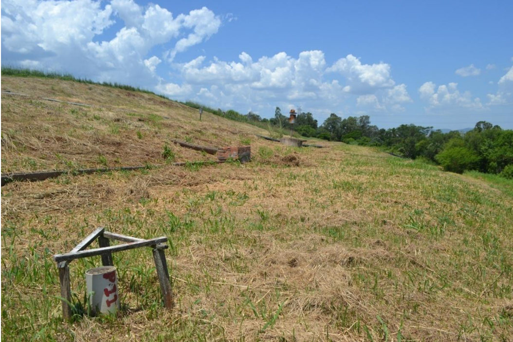
Figura 3.19 – Vista lateral do Aterro E. Fase I de São Leopoldo encerrado com o marco superficial P11.
