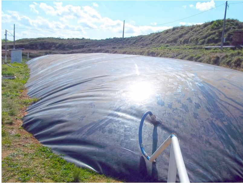
Figura 6 – Biodigestor modelo lagoa coberta
